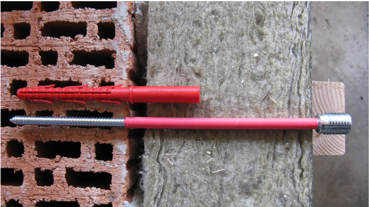
Abbildung 2: Querschnitt bei Verwendung von Hochlochziegeln als Untergrund
