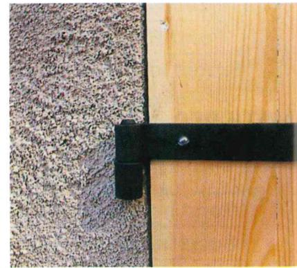
9. L'ouverture des volets est possible après vérification du durcissement de la résine.
