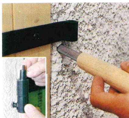
4. Mettre en place le filtre à l'aide de l'outil de pose. Avant d'injecter la résine, nous vous conseillons de contrôler si votre perçage est correct à l'aide du gond et de la clavette.
