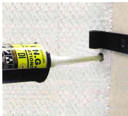
5. Enfoncer la canule au fond du trou, puis la ressortir de 5 mm environ, et ensuite injecter la résine en respectant la graduation. Lorsque la résine est injectée, il faut placer le gond immédiatement.
