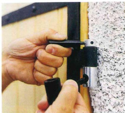
1. Avant la mise en place, nous vous conseillons d'assembler les 2 volets et de les maintenir à l'aide de coins. Mettre en place le gabarit orientable et le serrer à l'aide du gond.
