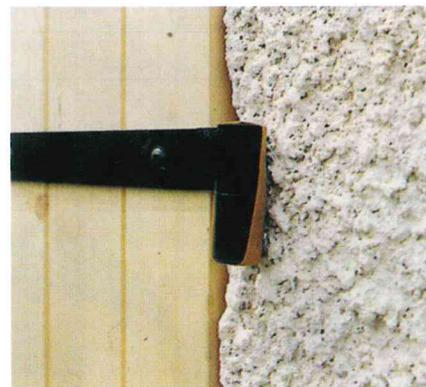
8. Mettre l'élastique pour maintenir le gond pendant le temps de séchage de la résine-mortier.
