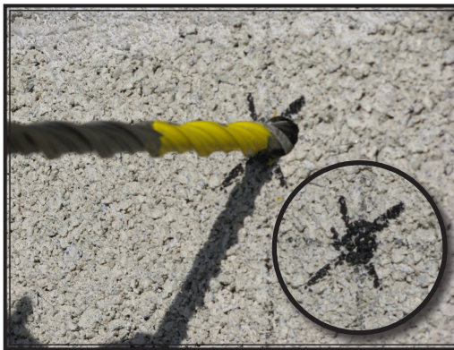
2 Percer Ø10 (les 2 alvéoles si parpaing). Repère jaune sur la mèche spéciale.
