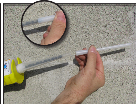
6 Bloquer la rallonge spéciale sur l'embout mélangeur. (voir photo n°10)
