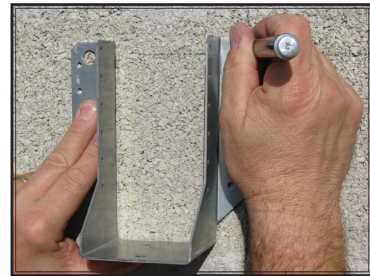
1 Positionner le sabot de charpente et repérer le trou.
