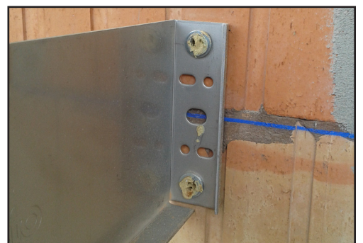
Fixation d'équerre de bardage sur la brique
