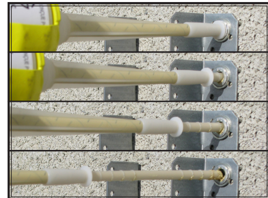
7 Injecter la résine en retirant la canule et respecter les graduations. Répéter cette opération pour les 4 clous.
