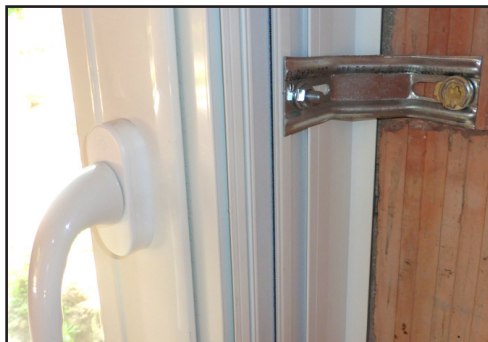
Fixation de menuiserie PVC sur la brique
