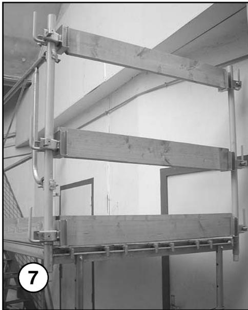
Installer les fixes plinthes à hauteur 50 cm et 1 m puis emboîter des plinthes latérales qui serviront de garde corps.
