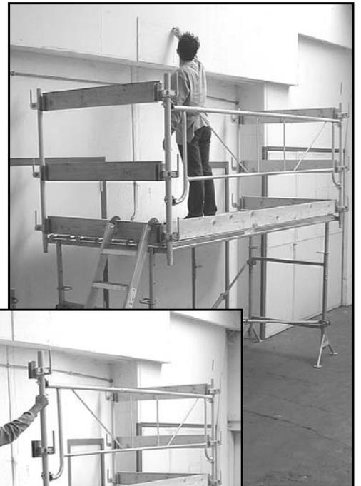
L'ensemble est complètement monté et vous permet de travailler jusqu'à 4m. Pour accéder ou descendre de la plateforme, utilisez une échelle après avoir retiré deux plinthes comme ci dessous.
